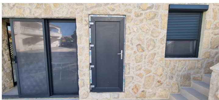
„S4” jelű lakás bejárata A parkolóból a jobb oldali lépcső mellett
