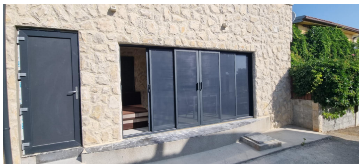
„SG3” jelű lakás bejárata Az aszfaltos út felől, a jobb oldali terasz
